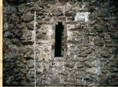
Obergasse 11: Fenster aus dem frühen 14. Jh.
