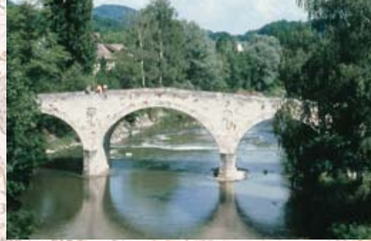
Bogenbrücke von 1808 in Rorbas. (Foto Cornel Doswald, IVS)
