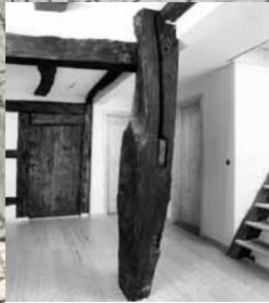
Typisches Merkmal des Hochstudbaus: mächtiger, durchgehender Ständer.
