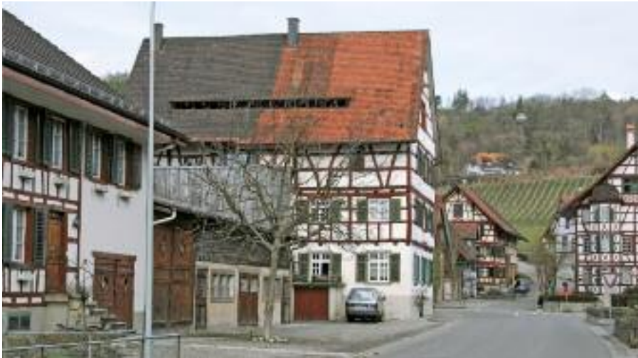
Statt einer gängigen Giebellukarne wurde hier in Oberstammheim eine individuelle Lösung mit Dachabsatz gewählt, die wie eine traditionelle Belüftungsgaube wirkt.
