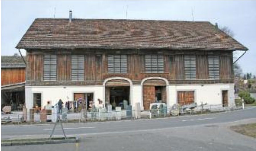
Nicht jedes Gebäude eignet sich zum Wohnen. Nach der Erwägung verschiedener Nutzungskonzepte wurde diese Scheune nach denkmalpflegerischen Grundsätzen restauriert und dient heute gewerblichen Zwecken.
