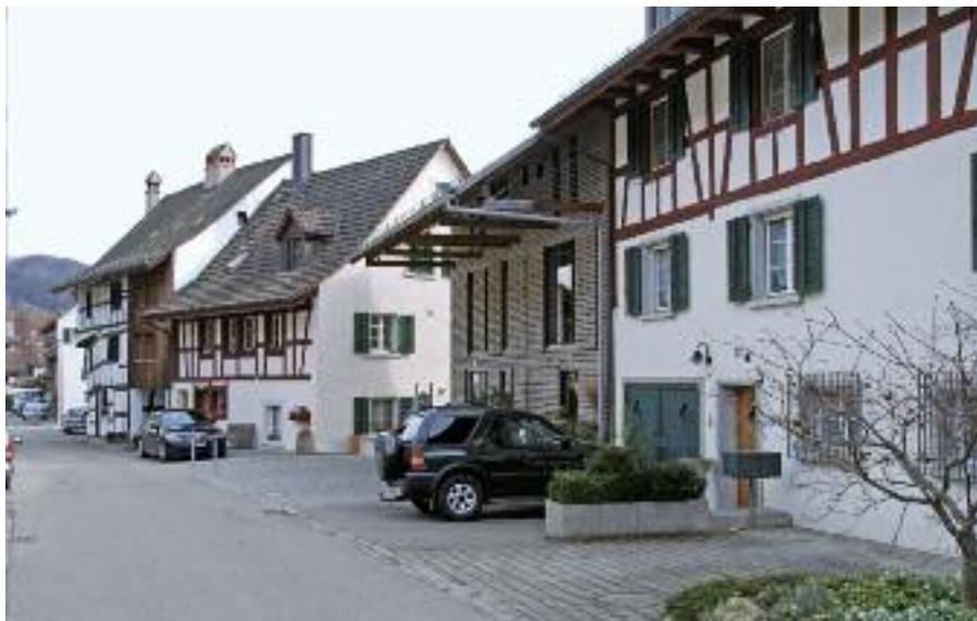
Als geschlossene Holzfassade zwischen den benachbarten Riegelbauten behauptet sich dieser Ersatzneubau in Eglisau unaufdringlich. Die Struktur von gemauertem Stall und der darüber liegenden Scheune in Holzkonstruktion wurde fallen gelassen, weil das Haus nicht mehr horizontal genutzt wird.
